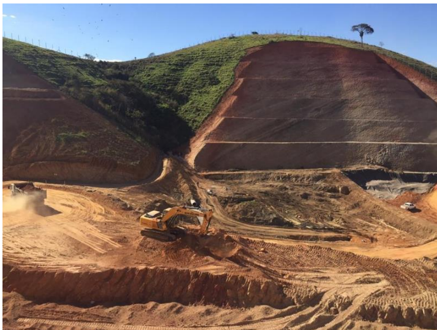
Figura 3: O Aterro Sanitário do município de Três Rios, RJ, durante a obra.
