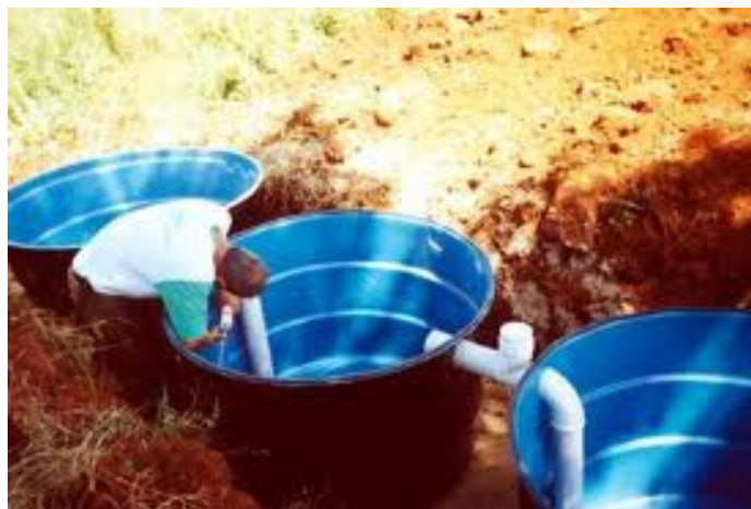
Figura 3. Instalação da Fossa Séptica Biodigestora. Fonte: EMBRAPA (2010)
