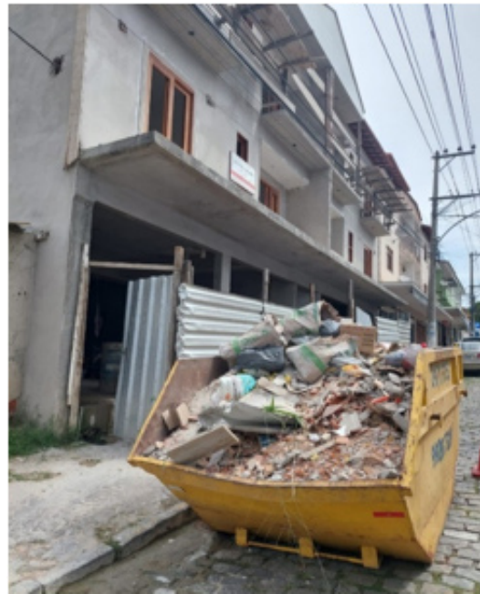
Figura 3. Resíduos de Construção.Civil armazenados em caçamba.
